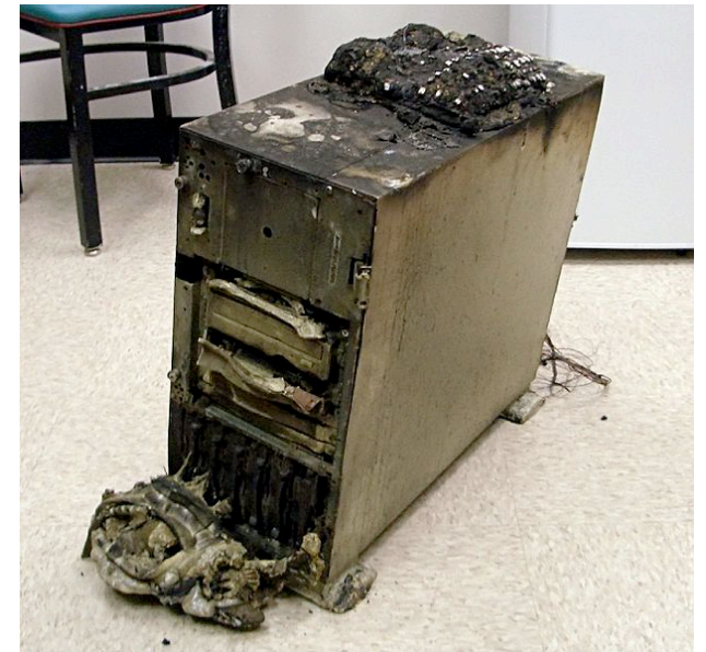
Zerstörter Backup-Server durch Brand
